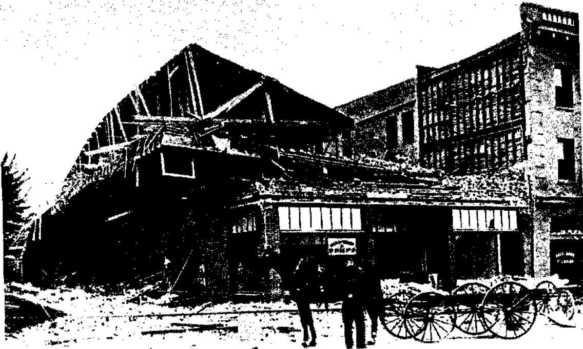
L. Wreck of 2-story trick building, San Mateo. Per J. O. B.
